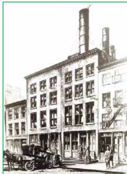
エジソンがニューヨークにつくった石炭火力発電所
